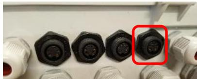
Figure 9 – Embases Modbus Hub sur la CCU/DCCU
