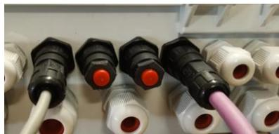
Figure 65 – FAC à droite plus un appareil, 2 bouchons
