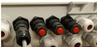
Figure 64 – Un seul appareil connecté, 3 bouchons
