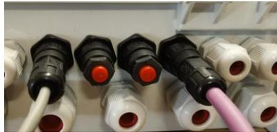
Figura 67 – Sonda cloro direito mais um dispositivo, 2 tampas
